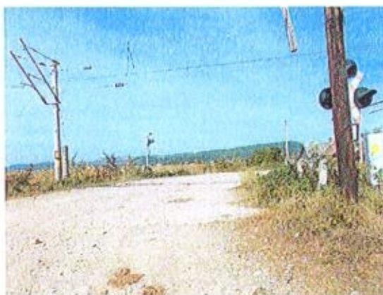
Fig. 5 Intersecție cu calea ferată
